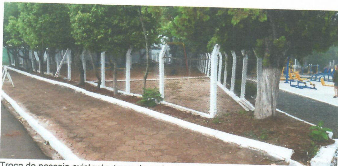
Troca do passeio existente, troca da areia da pracinha.
